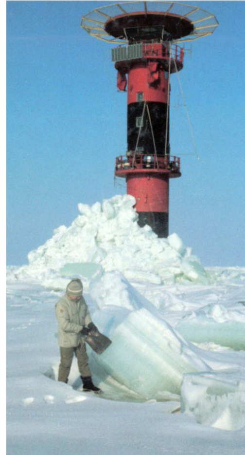
Jäävalli on murtunut Kemi I majakan ympärille rakennettua jääkuormien mittauskartiota vasten ankarana jäätalvena 1986.
